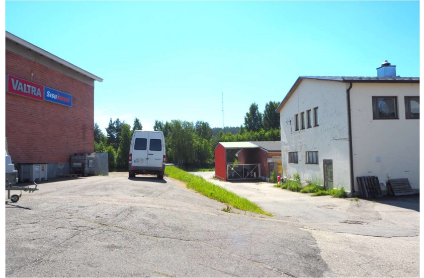
Rakennuksen luoteispuolella on vanha mylly sekä taustalla näkyvä matala varastorakennus.
