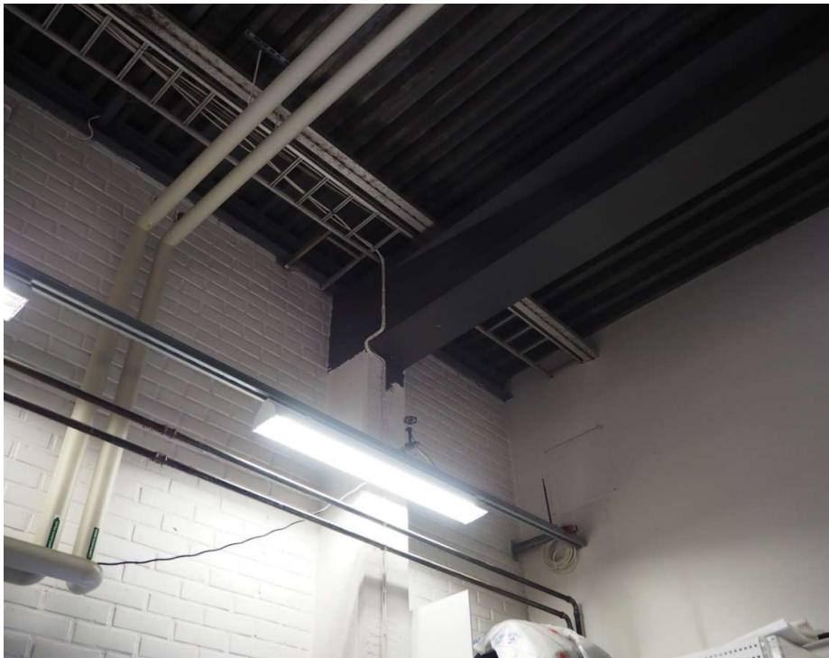
Päätytiiliseinää vasten on sijoitettu betonipilari, jonka päällä on primäärikannak-keena toimiva teräspalkki. Sisäkaton verhoilu on peltiä.
