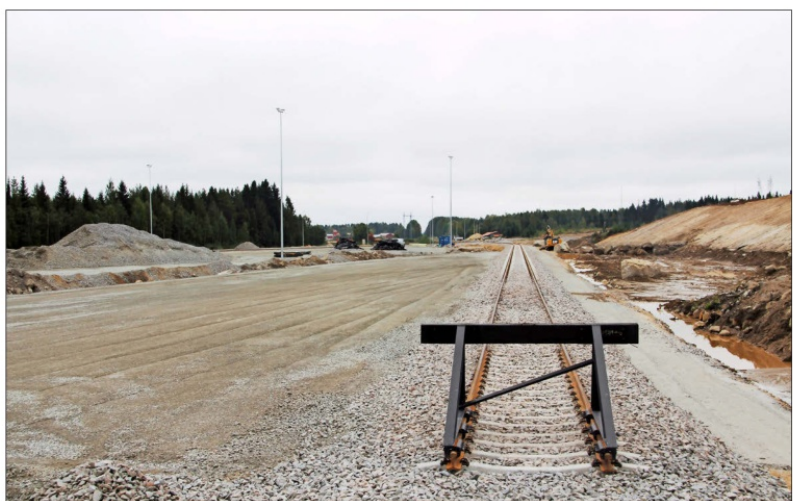
Känkkäälän raakapuutermiinaalin rautatie on paikoillaan. Termiinaalin on tarkoitus olla luovutuskunnossa lokakuussa. KUVA: HENRI JOKELA
