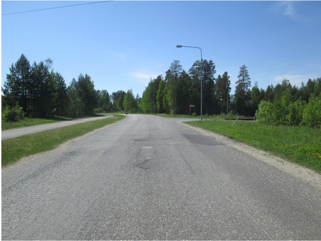
Valokuva 2. Pitkänmäentie Voimatien liittymästä Kuopiontielle päin.
