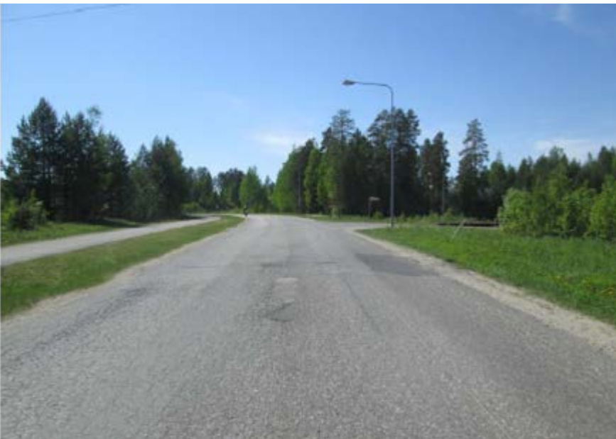
Kuva 16.2. Pitkänmäentien Voimatien liittymästä Kuopiontielle päin.
