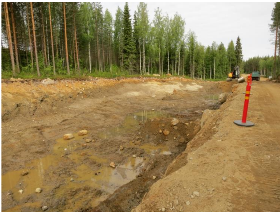
Kuva 10.1. Voimatien uuden linjauksen työmaa on paljastunut kallion suunnitellun biohiiltämön länsireunalla. Kallion päällä on vettäpidättävä harmaa hiesu-savikerros ja päällimmäisenä kivinen hiekkamoreeni. Kuvaussuunta on luoteeseen.
