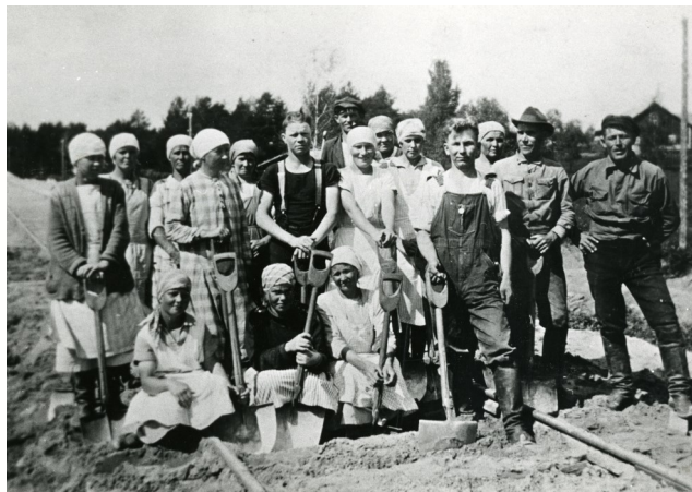
Topparoikka Lipinlahdessa n.1910 Topparoikan tehtävänä oli kiskot asentavan rautaroikan jäljessä suoristaa ja tukea kiskot liikennöitävään kuntoon.
